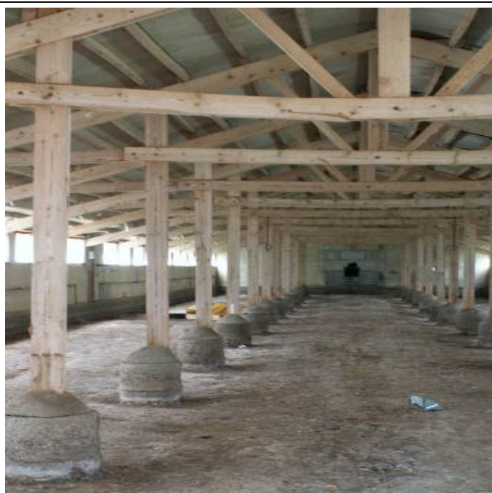
L'intérieur de l'un des hangars (Photo SG)
